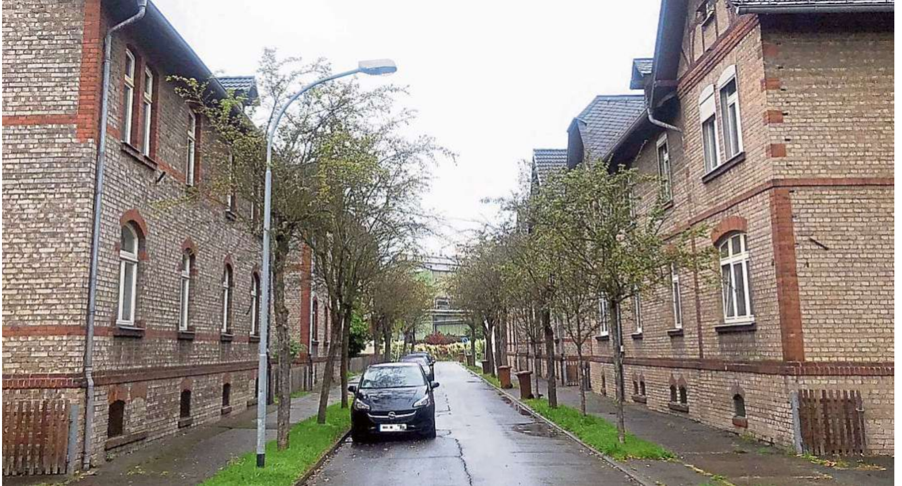
Die Buderus-Häuser in der Eisenstraße in Niedergirmes, einst gebaut für Werksangehörige, gehören zum Wohnungsbestand, welcher als Paket mit der Buderus Immobilien GmbH verkauft werden soll. Foto: Steffen Gross
